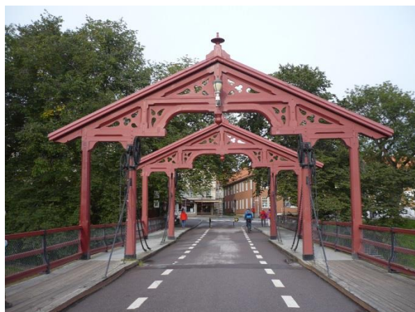
Bybrua, hölzerne Klappbrücke in Trondheim.
